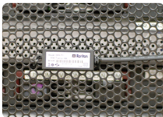
サーバラックの冷気吸気口にマウントされた温度センサの例。センサはインテリジェントPDUに接続（写真中表示なし）
